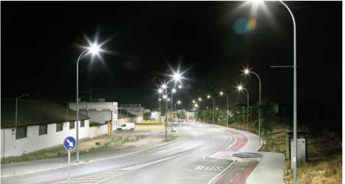
Alumbrado público 📍 Marinera de Alcor (Sevilla)
